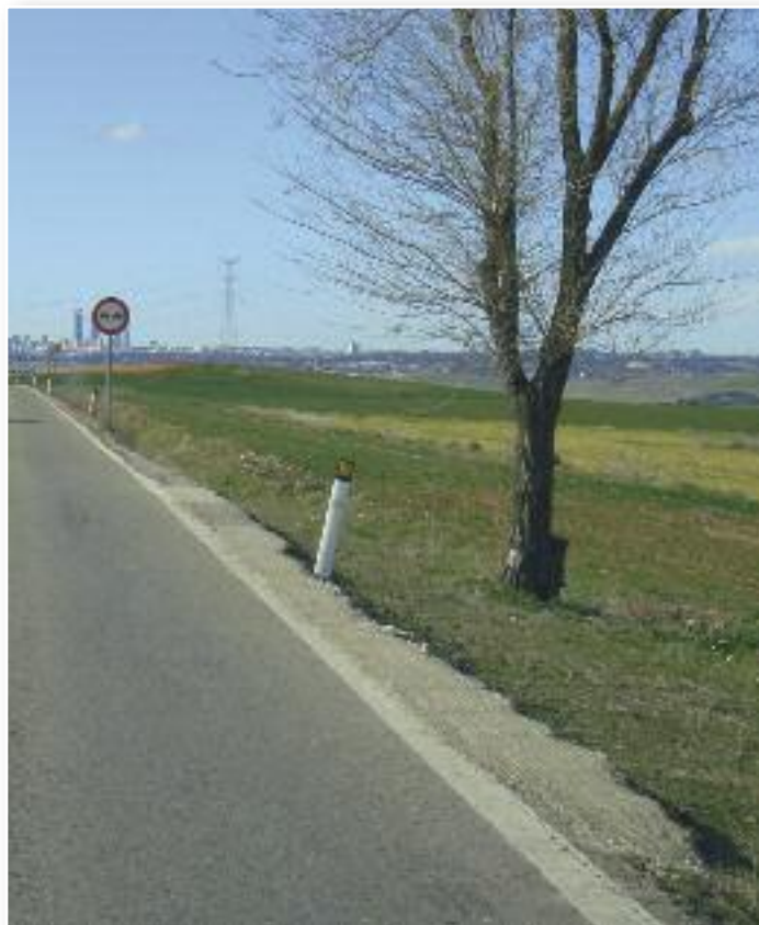
"Mejoras en el arcén" en la carretera M-103, tramo M-111
